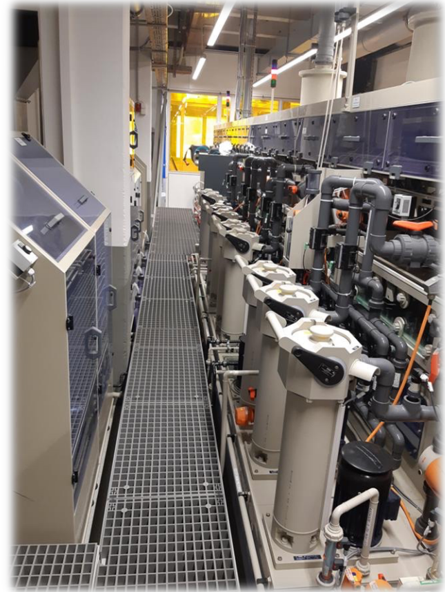
Dosing consoles integrated into the system システムに統合された投与コンソール
